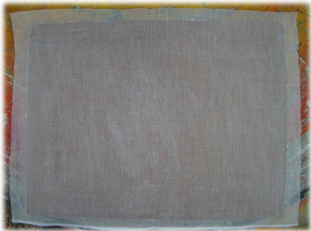
ใช้ผ้าขาวบางหรือผ้าดิบชนิดไม่ฟอก ปูทับลงบนพื้นไม้
