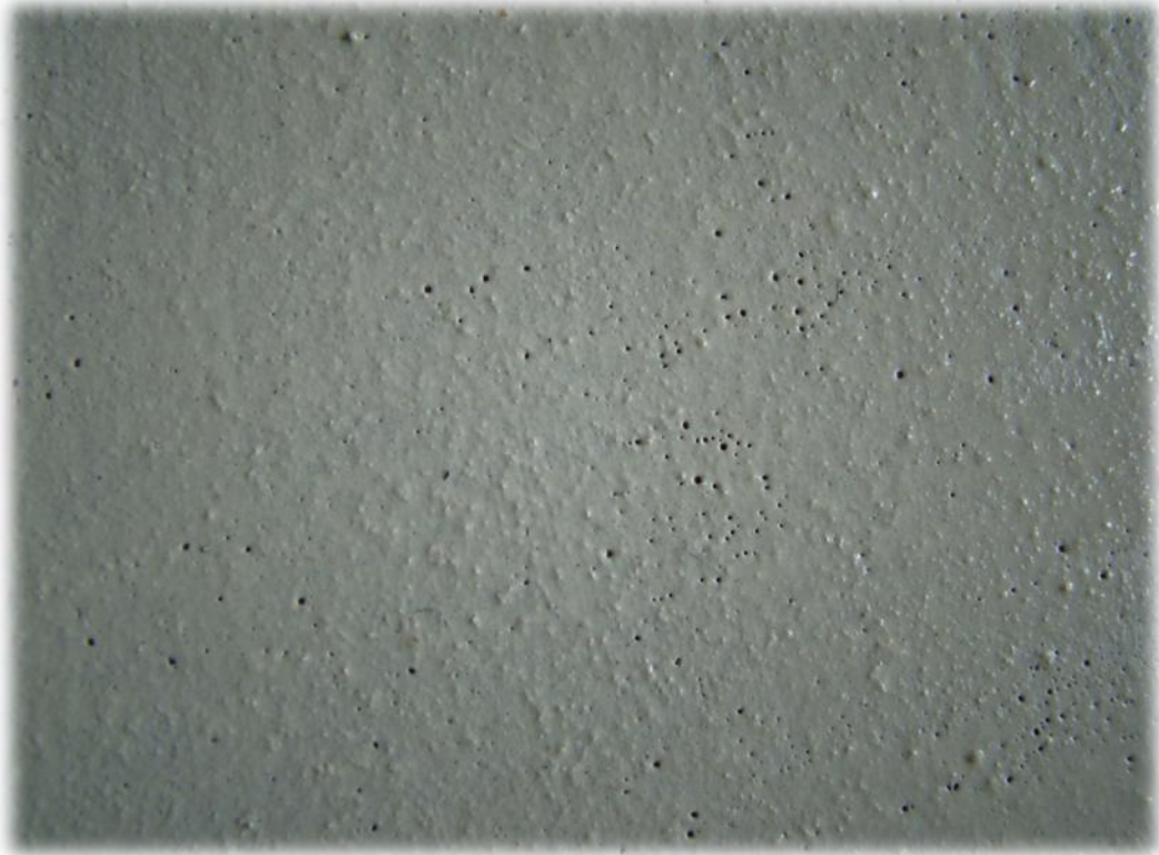
หากมีรูฟองอากาศต้องตากลมให้ทั่วเสียก่อน
